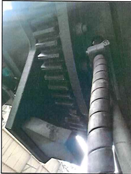
Local: Spreader Item # 28: coroa de giro do spreader possui 2 dentes quebrados, porém os mesmos estão do lado oposto à redutora de giro.
